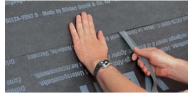
DELTA®-VENT S PLUS ile rüzgar geçirmeyecek şekilde döşenir.
