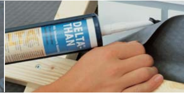
Bağlantı bölgesi DELTA®-THAN ile güvenli yapıştırılır.
