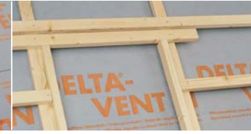
Çatı pencere montajında detaylar.
